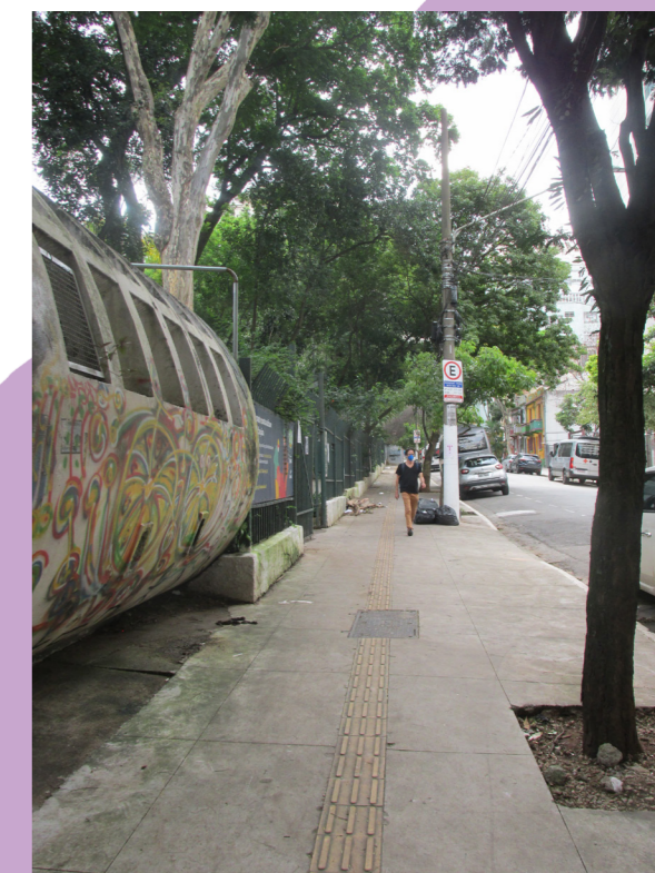
Imagem 6 - Piso tátil com interrupções
