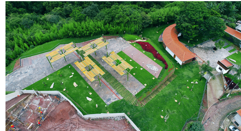
Imagem aérea com destaque para a cobertura multiuso (em finalização), à esquerda Teatro Dom Silvério (em obras) Crédito: Rodrigo Gouvêa
